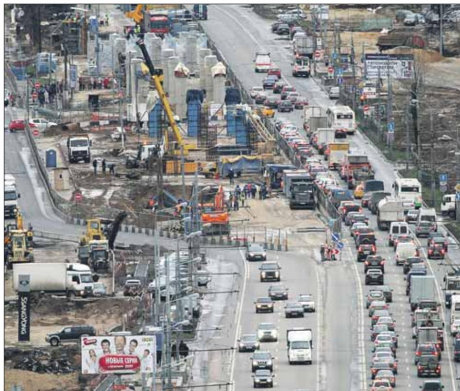
Строительство на пересечении Ярославки и улицы Вешних Вод. На переднем плане — опоры колонны будущей эстакады
