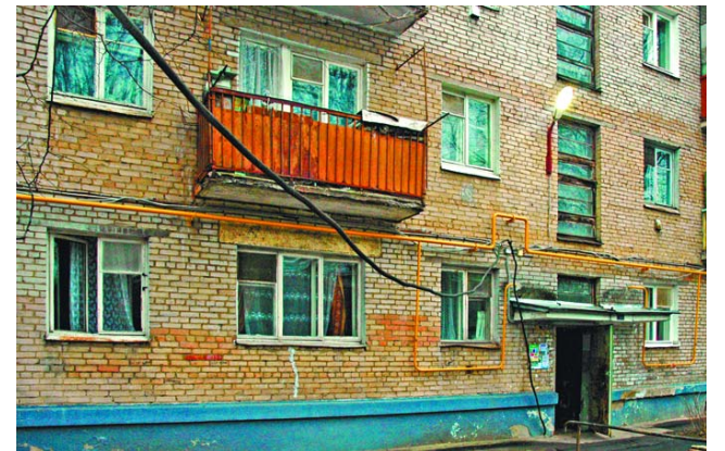
Электроснабжение дома 34 ведется по временной схеме, но проект прокладки нового кабеля уже заказано
