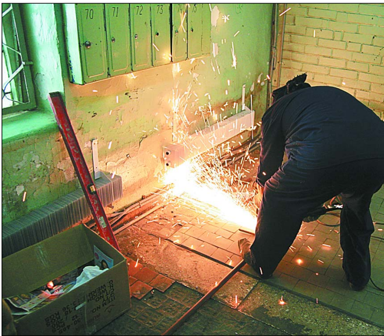
На Изумрудной, 42, ремонт заканчивается
