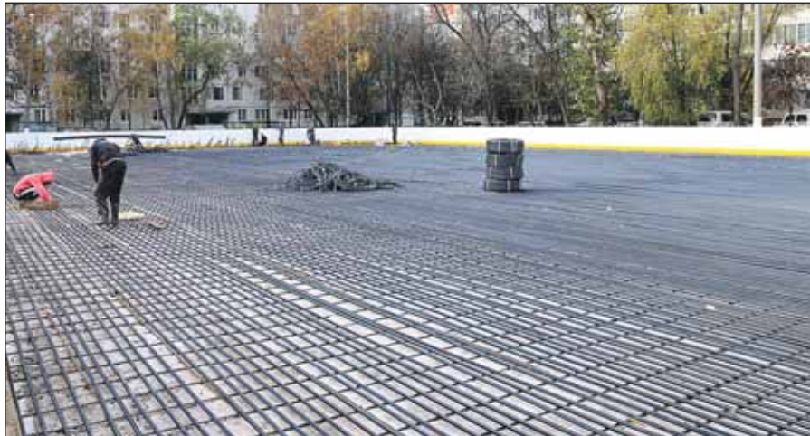
Идёт работа на улице Декабристов, 29
