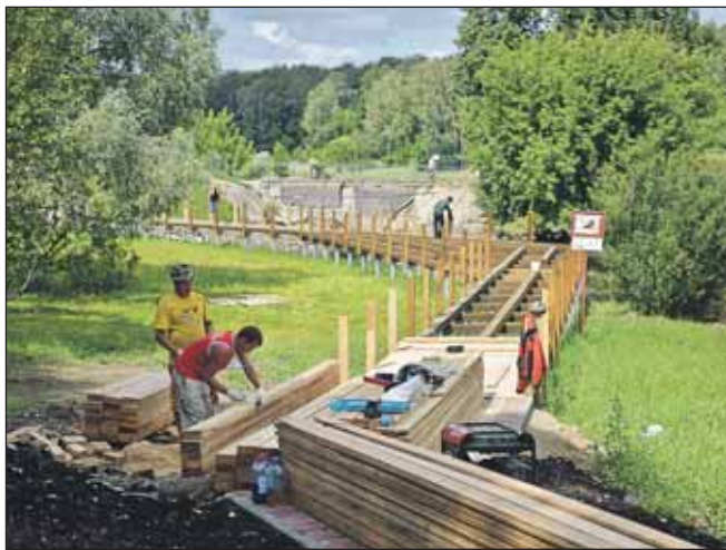
Капитальный ремонт пруда намечено закончить в декабре
