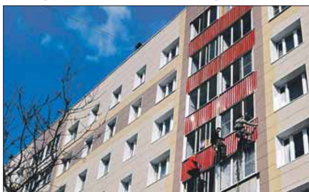
Капремонт в доме 9 на 9-й Северной линии
