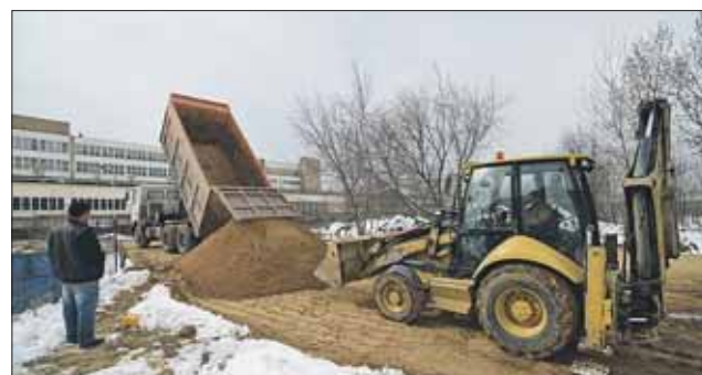
Строители выравнивают площадку под фундамент
