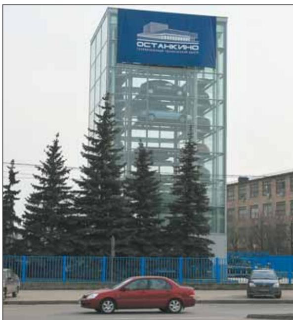
У телецентра «Останкино» построили 9-этажное здание на участке в 100 кв. м — на 34 авто. Машина в такой парковке въезжает на автоматическую платформу, которая за минуту доставляет на заданный оператором уровень. Благодаря стеклянному фасаду автомобили видны как на ладони. Парковка построена с использованием современных материалов и адаптирована к нашему климату.
