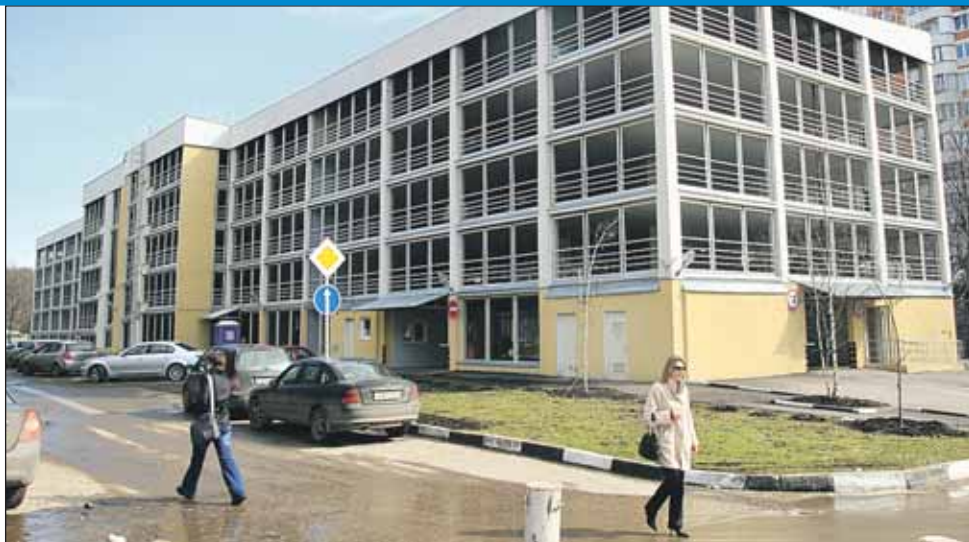
Паркинг на Полярной, 39, заполнен практически до отказа
