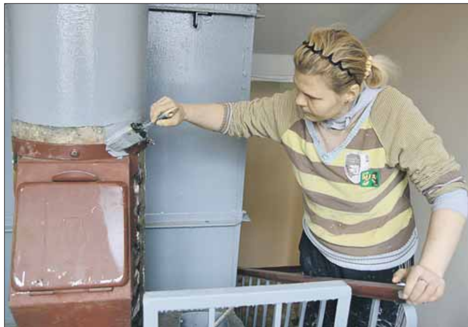
Ремонт подъезда 3 на улице Бутырской, 6
