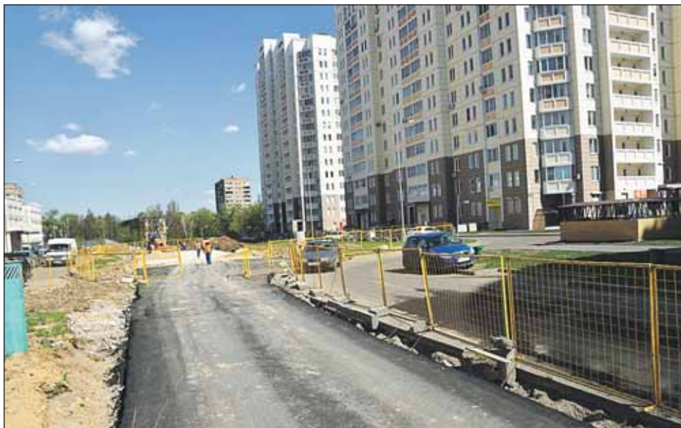
Первый участок новой дороги уже покрыт слоем асфальта
