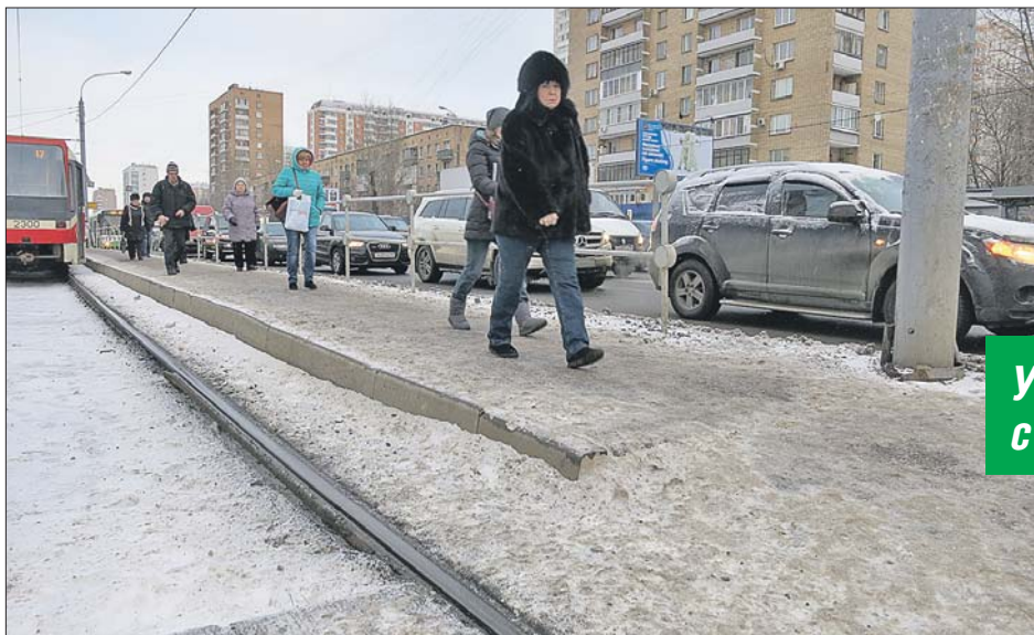
Даже небольшой снег или наледь делают опасным спуск к трамвайным рельсам на пересечении Полярной и Дежнёва
