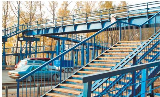
Тихо, без разрезания алой ленточки, на 22-м километре Дмитровского шоссе открыли надземный переход. Металлическая конструкция шириной 3 и высотой 4,5 метра имеет пандусы для инвалидов и отдельные пологие спуски и подъемы для колясок.
