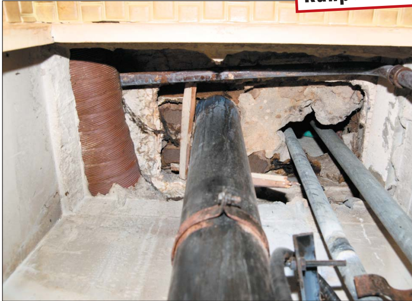
Так выглядит потолок в санузле после ремонта
