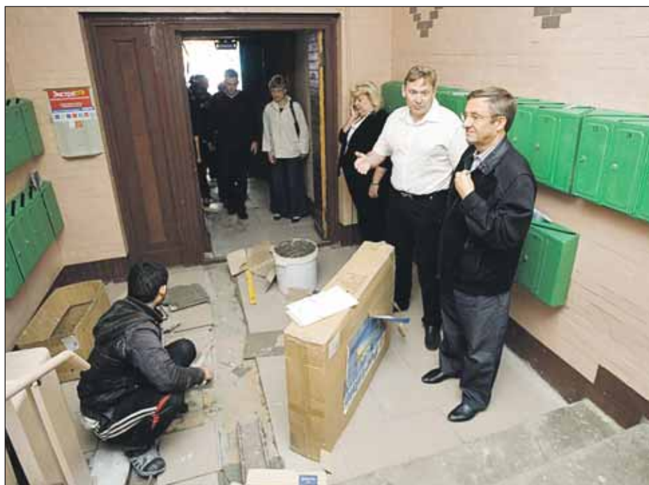
Префект посмотрел, как идёт ремонт подъездов
