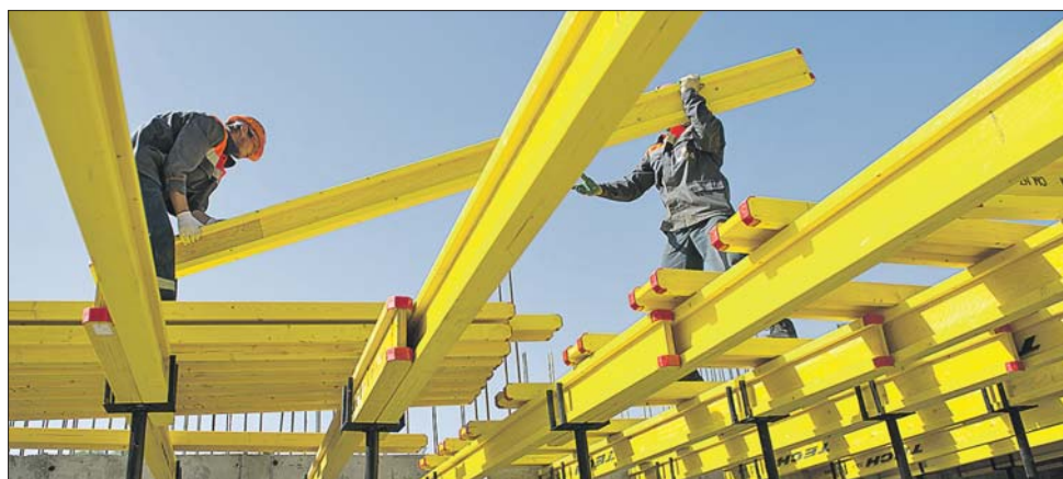
Завершить строительство технопарка планируют в конце 2014 года
