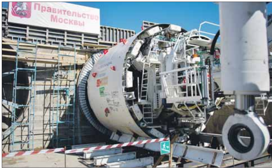
Идёт монтаж уникального тоннелепроходческого комплекса
