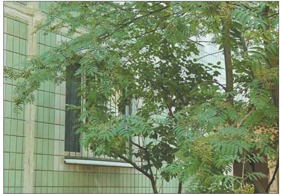
На первом этаже дома 2, корп. 2, по Холмогорской улице окна закрыты деревьями
