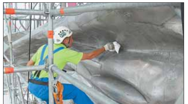
На скульптуру наносят антикоррозийное покрытие
