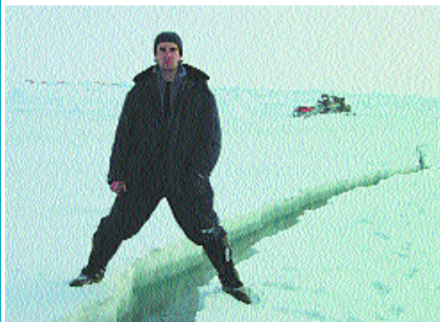
Трещина прошла по взлетно-посадочной полосе
