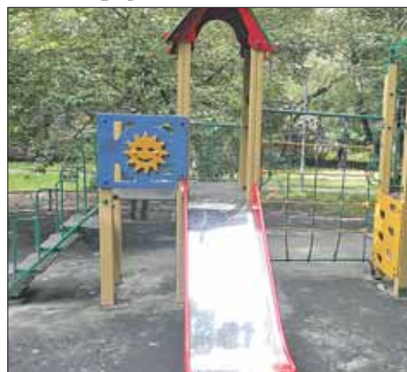
Старую горку перенесли на площадку временно ница, сделаем и мягкое полиуретановое покрытие. Срок окончания работ — 31 июля.
