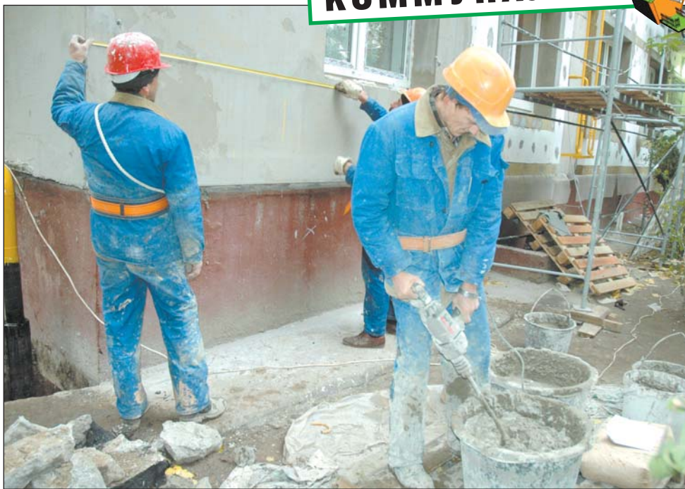
Рабочие ООО «РТ-строй» утепляют фасад дома 8 по Печорской улице
