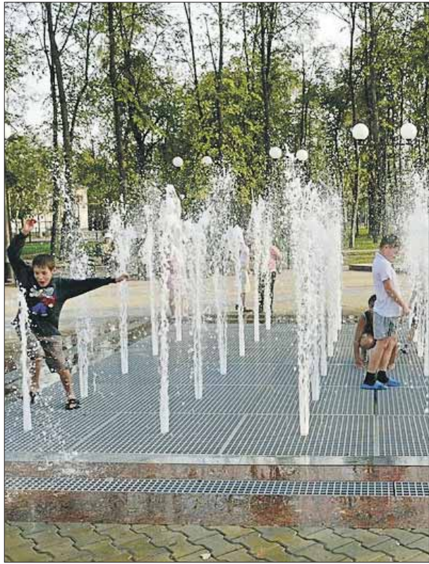
В «сухих» фонтанах вода сразу через решётки уходит под землю
