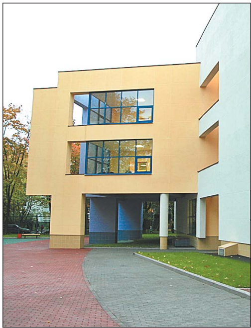
Так пристройка к 274-й школе выглядит снаружи...
