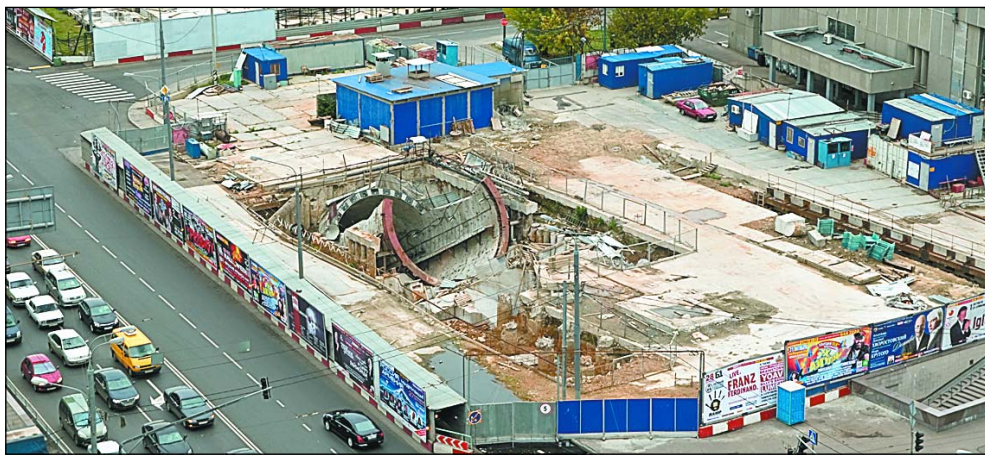
Идет строительство наземного вестибюля станции метро «Марьяна Роща»
