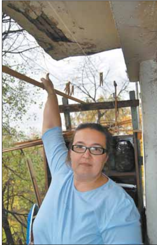
Наталья показывает на аварийный балкон
