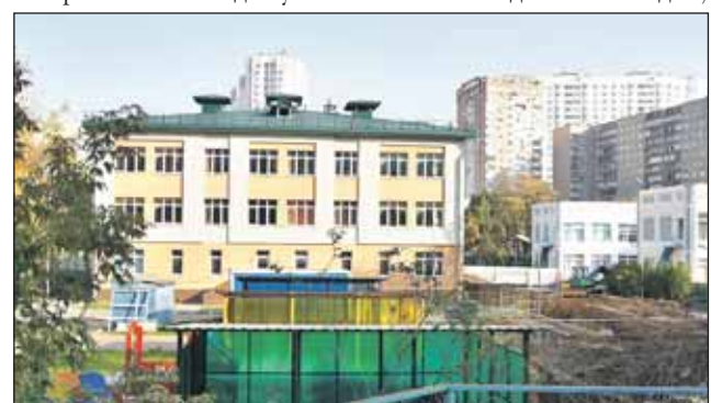
Близится к завершению строительство детского сада на Алтуфьевском шоссе, 40
