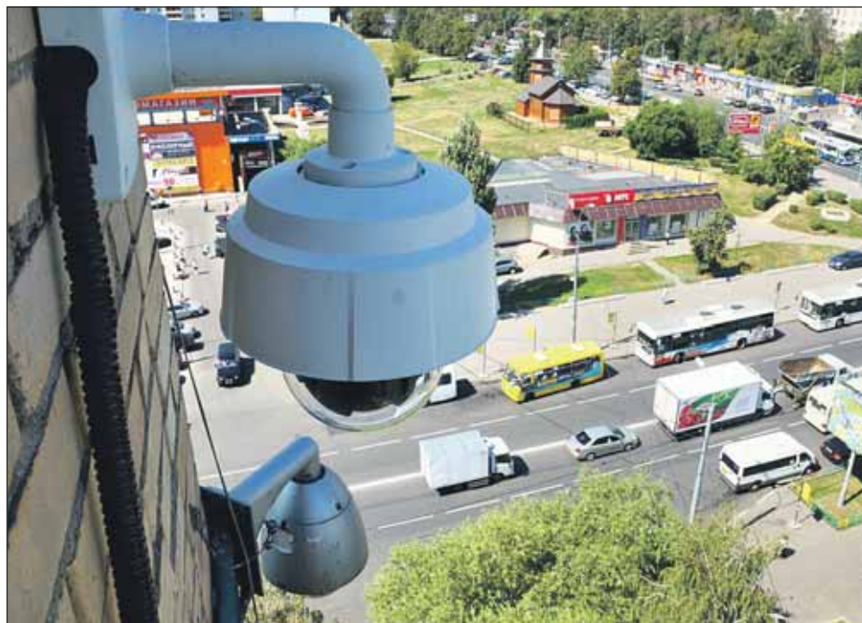
Камера видеонаблюдения на улице Грекова, 8, фиксирует дорожную ситуацию на перекрёстке улиц Широкой и Грекова
