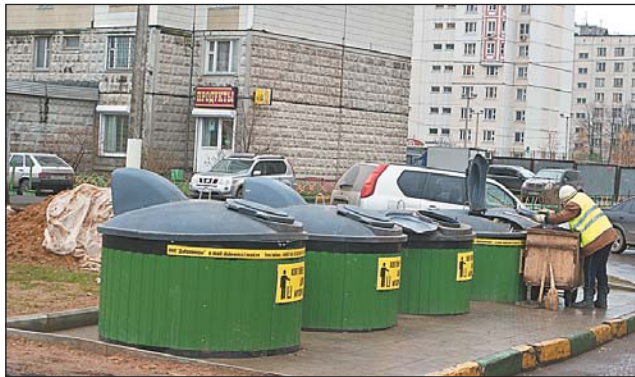
Надземная часть подземного бункера на Зеленоградской улице в Ховрине
