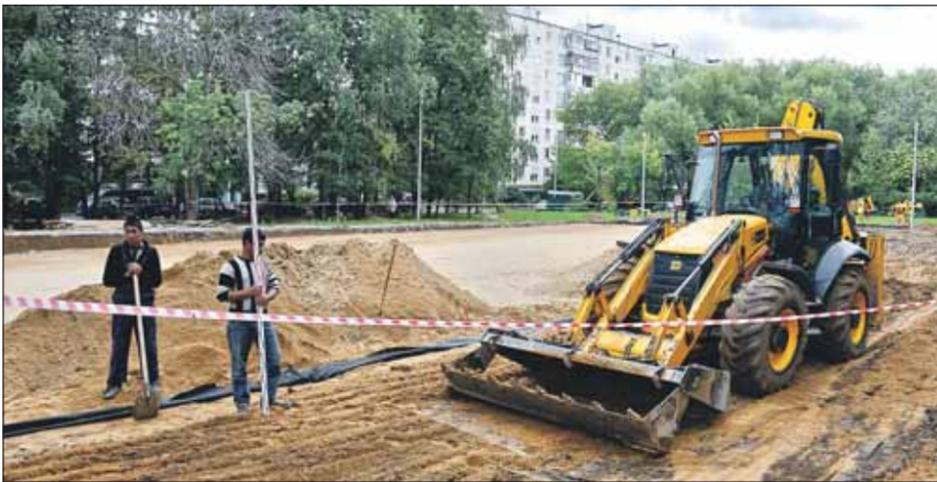
На Студёном, 34-38, уже вырыли котлован для бетонной плиты, на которую положат холодильную систему
