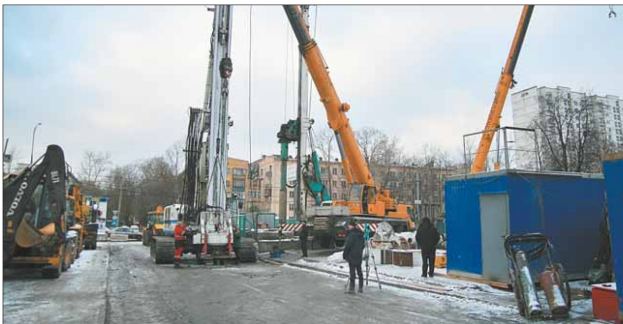
Строительство нового выхода из метро «Марьиная Роща»
