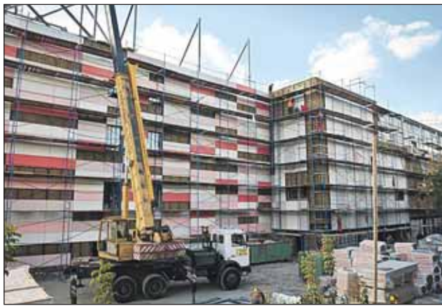
Фасад «Планеты КВН» будет навесным, с подсветкой изнутри
