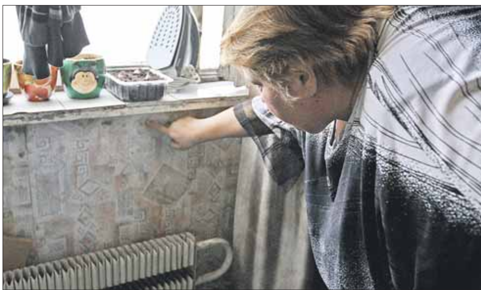
В квартире Елены Силуяновой отошли обои, недавний ремонт — насмарку
