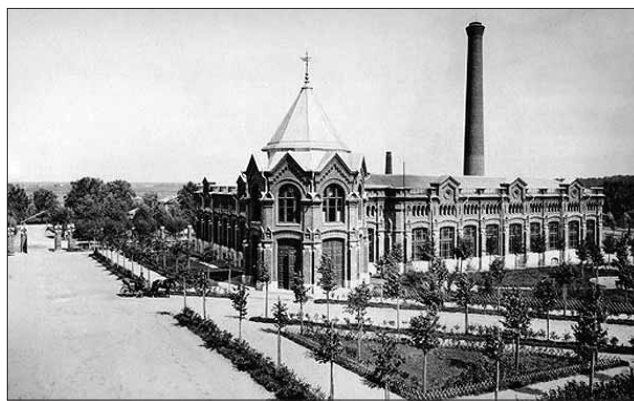
Алексеевская насосная станция (завод «Водоприбор»), 1913 г.
