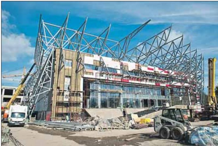
тонах. Монтаж несущих конструкций под декоративную оболочку завершён. На прошлой неделе панели шести разных оттенков начали крепить на специальных скобах.
