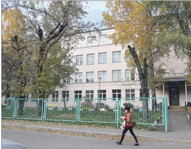
Здание 1938 года постройки требует ремонта
