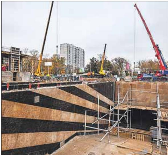
При строительстве наклонных тоннелей, в которых располагаются эскалаторы, на станции «Марьино Роща» впервые в мире применили механизированный тоннелепроходческий комплекс канадского производства (ранее подобные работы выполнялись вручную). Станция — глубокого заложения (глубина — 60 метров), поэтому длина эскалатора — 108 метров.
