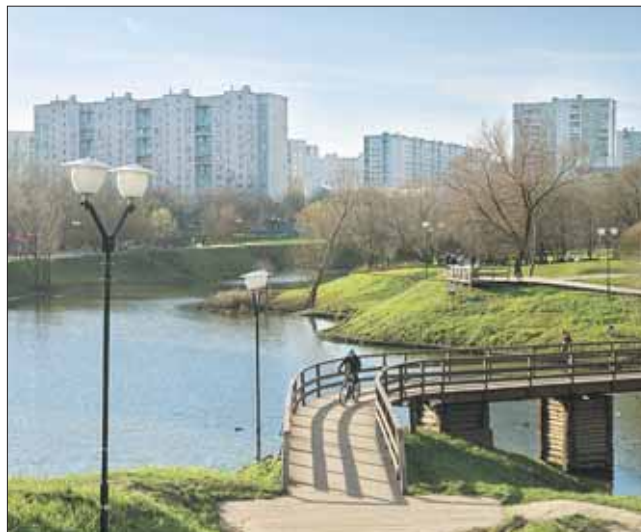
Запланирован капремонт двух пешеходных мостов
