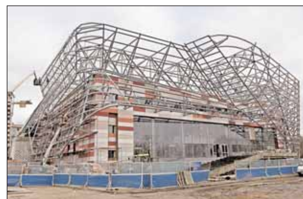
Строительные работы обещают закончить к 20 декабря
