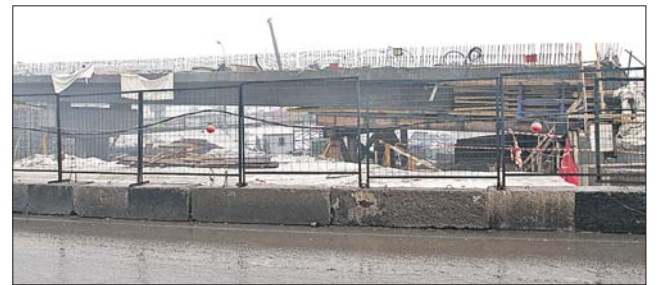
Сооружение пролётов эстакады близится к завершению
