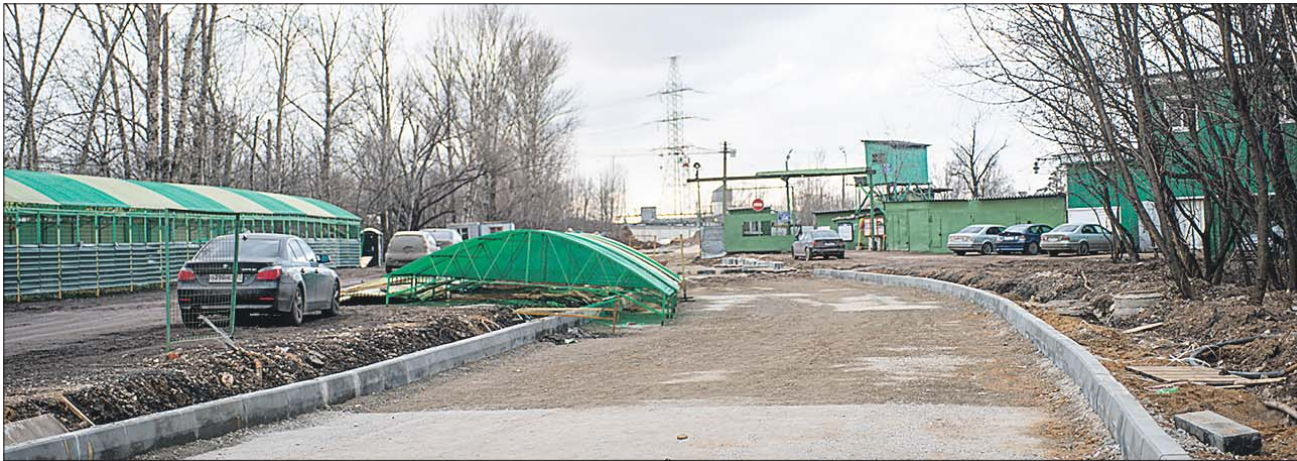
Строящийся участок новой дороги от Малой Ботанической до улицы Комдива Орлова
