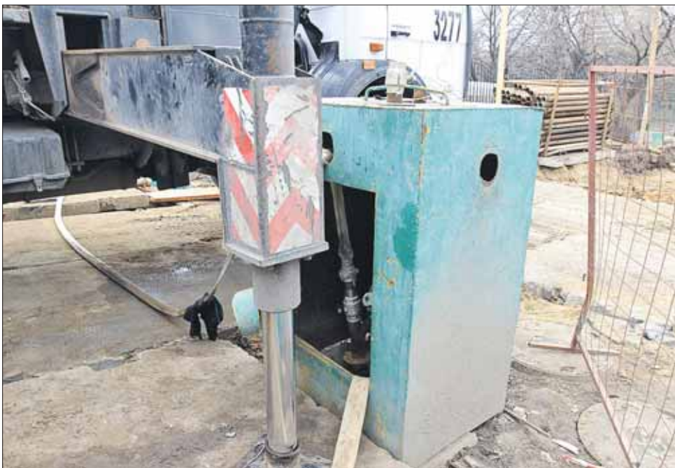
В ходе реконструкции Ростокинской улицы гидрант демонтируют
