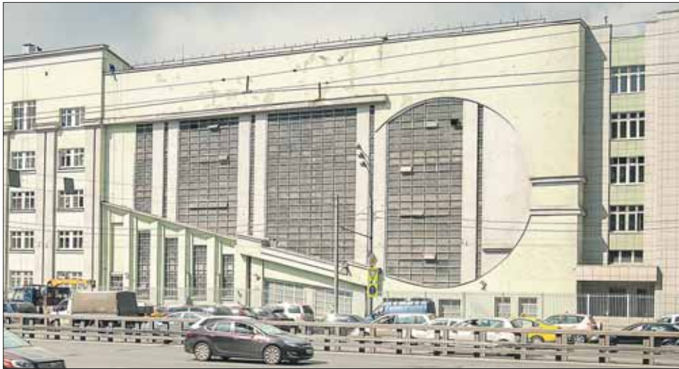
Гараж на Сущёвском Валу, 33, — ровно наполовину реализованная задумка знаменитого архитектора
