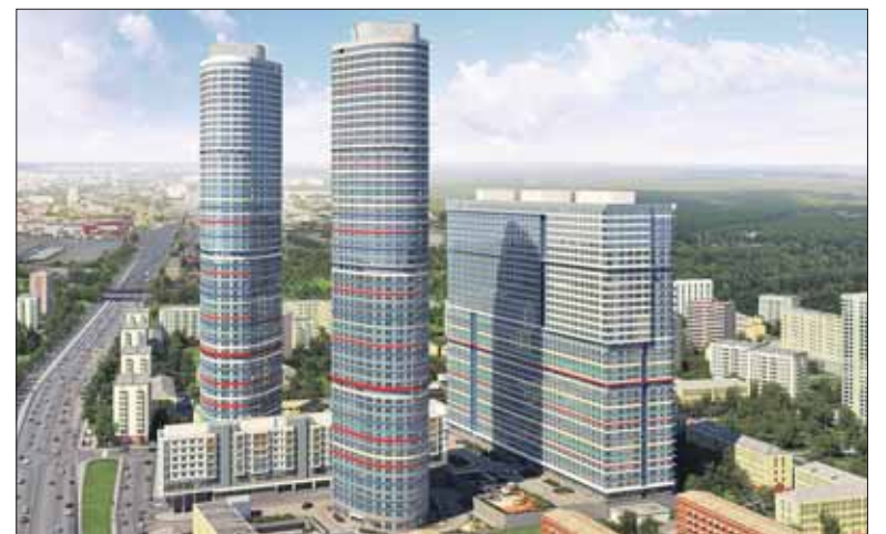
Строительство развязки у нового комплекса пока приостановлено
