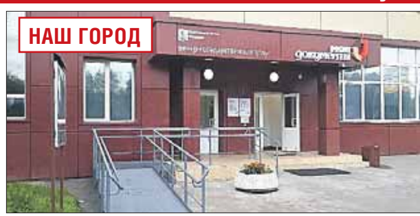
Пандус у входа в центр госуслуг района Северное Медведково
