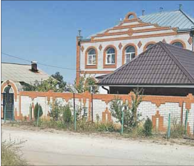
Судя по дому в цыганском посёлке в Волгограде, «беженец» не бедствовал
