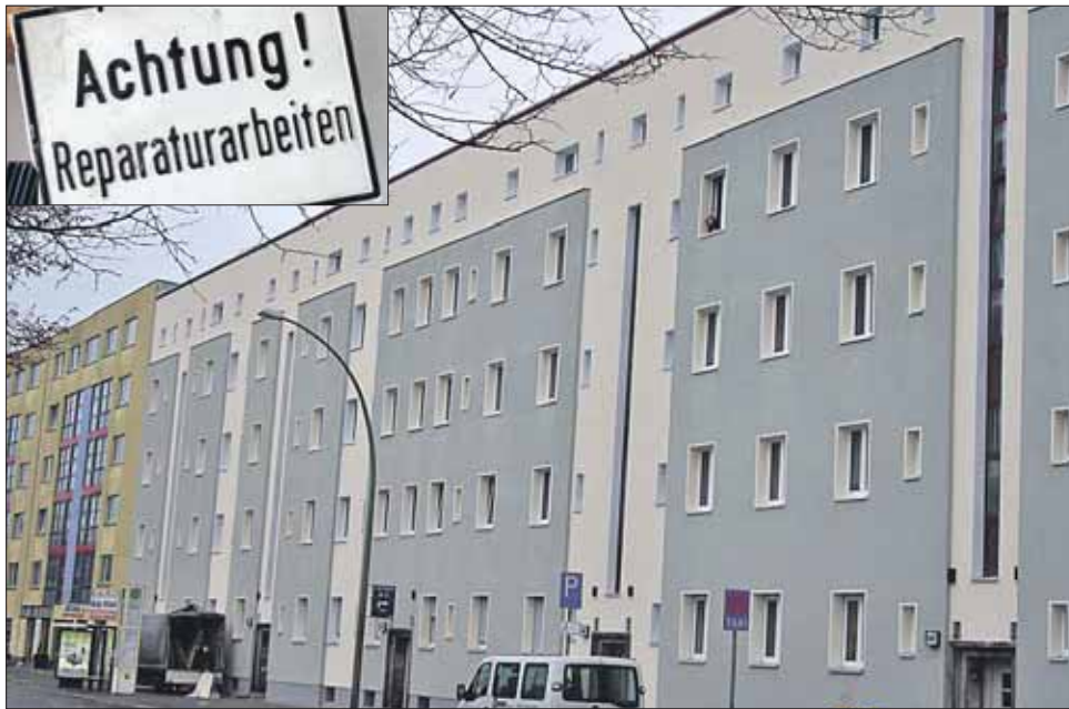
Капитальный ремонт этого жилого дома на Либрманштрассе в Берлине обошёлся в 2,8 млн евро
