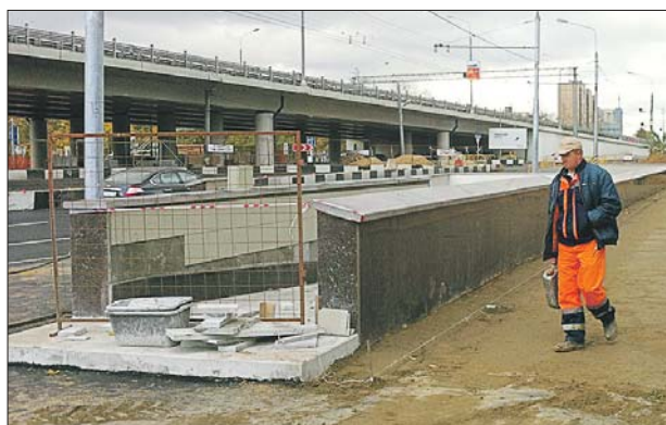
Переход стал на 60 метров длиннее
