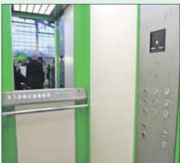
Разработан лифт, в котором застрять не страшно. Как только кабина остановилась, включается видеосвязь с диспетчером. Можно объяснить, что произошло, да и вообще не чувствуешь себя в изоляции. Кроме того, на пульте ремонтников в автоматическом режиме уходит СМС, и к вам выезжает мастер.
