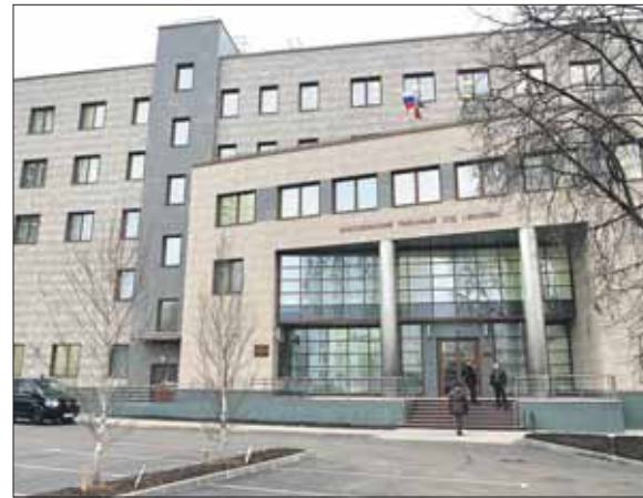
В новом здании будет 22 зала судебных заседаний
