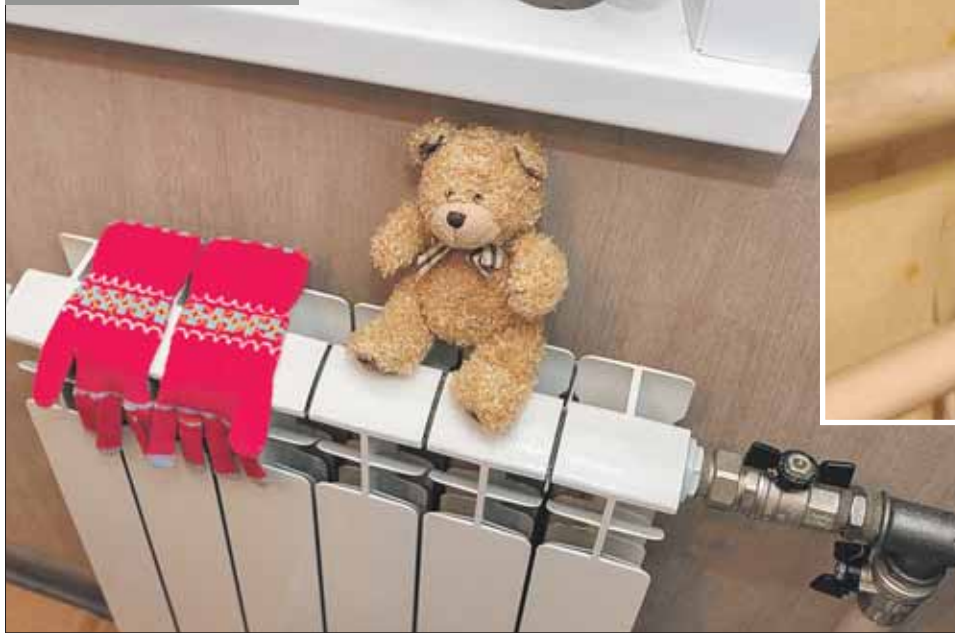
Ремонт систем отопления — важная часть программы капремонта
