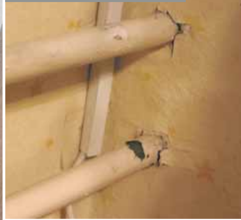
В домах с панельным отоплением наружу выходят только трубы, а стояки вмурованы в стены
