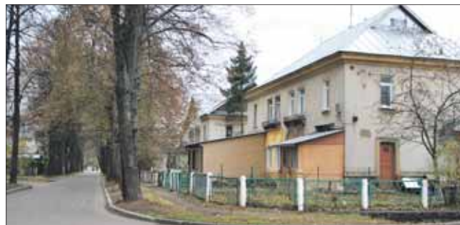
Прокуратура обнаружила нарушения практически в каждом доме
