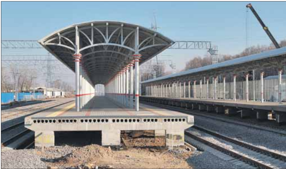
Работы на транспортно-пересадочном узле «Владыкино» кажутся наиболее близкими к завершению
