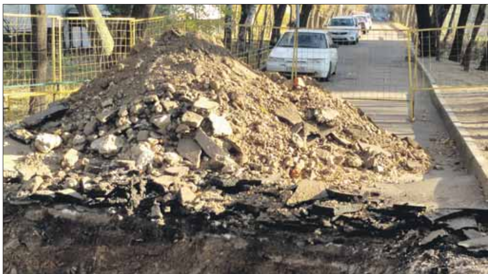
На улице Конёнкова, 9, строение 1, рабочие врылись в землю ещё в середине октября — и с тех пор никакого «шевеления»
