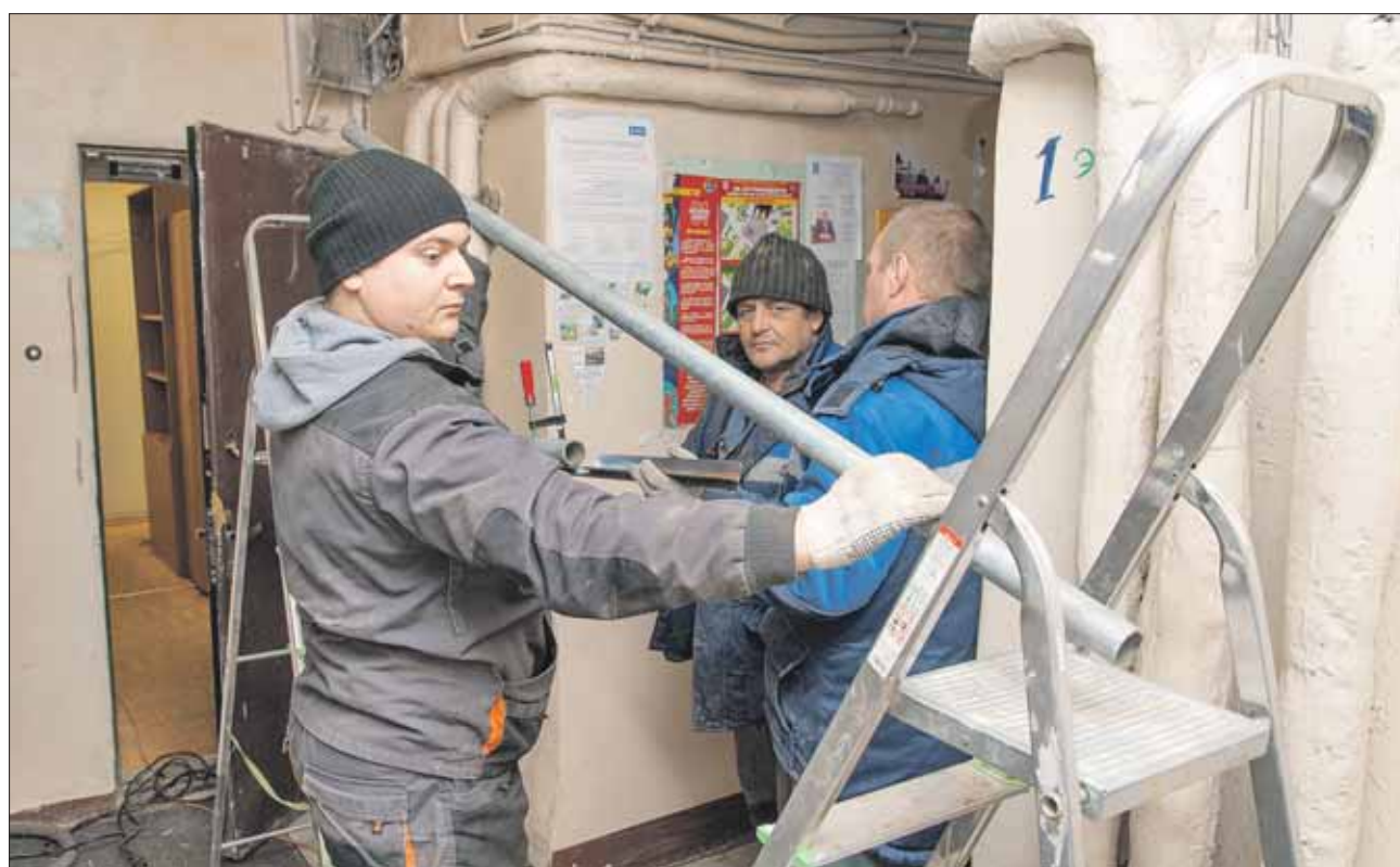
Пока капремонт ведётся на первом этаже дома, где находятся офисы
