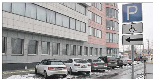
Общедоступный паркинг у центра госуслуг на 17-м проезде Марьиной Рощи, 4, корпус 1, оборудовали на средства, поступившие от платных парковок
