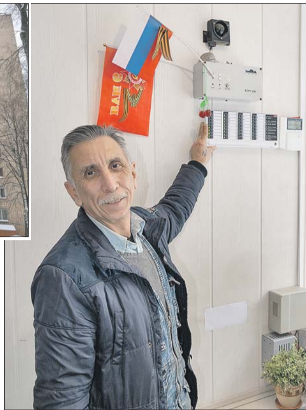
Новая система противопожарной автоматики подаёт сигнал тревоги прямо на пульт пожарным
