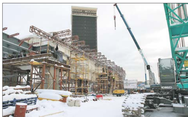
Контуры будущего съезда уже видны
