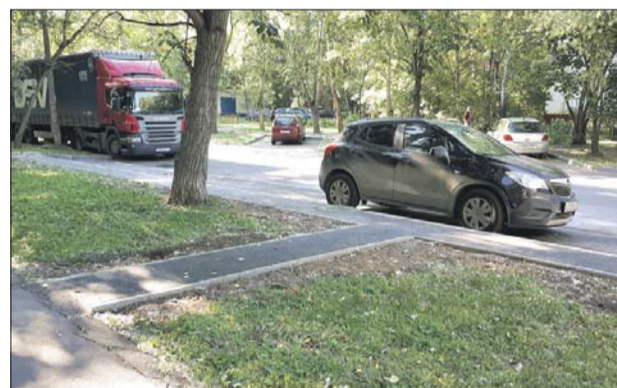
Технический тротуар на Инженерной, 11
