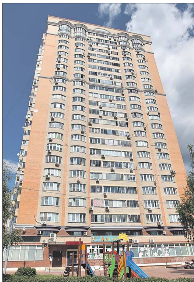
Облегчённый фасадный кирпич дома 5, корпус 1, на Псковской отслаивается при перепаде температур
