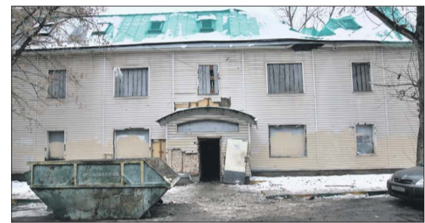
Собственника обязали привести дом в порядок
